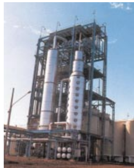
Figure 3. Distillation column from an ethanol production facility (Source: Cooperativa de Produtores de Cana Açúcar e Alcool de São Paulo Ltda - Copersucar, Brazil)
